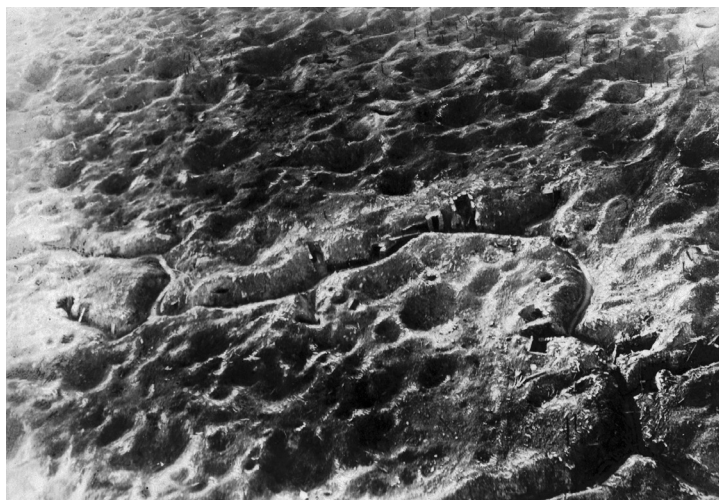
1. Photographie anonyme, Tranchées bombardées , vers 1917. Photographie argentique recueillie par Aby Warburg, Kriegskartothek , 1914-1918. Londres, Warburg Institute Archive (T 5082). Photo The Warburg Institute.
